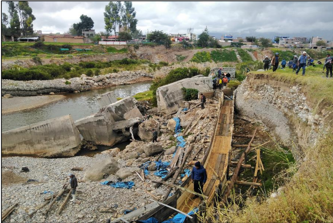
FOTO N°02: SE OBSERVA LA BOCATOMA DE LA COMISION DE REGANTES HUAMANCACA DESTRUIDO
